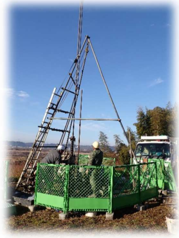
地質調査状況
